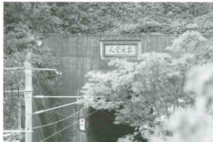
JR鹿児島本線城山トンネルの入口にある石碑
